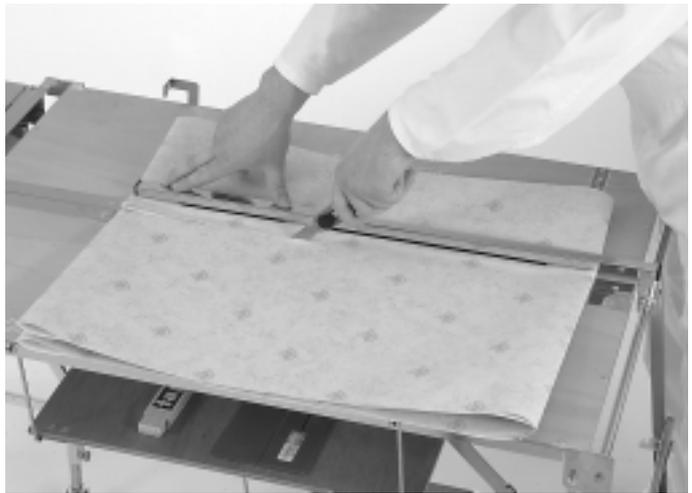
b) Danach den Anschlag anheben, in Richtung des Schneidspaltes führen und auf der Tapete ablegen, ohne diese zu verschieben. Den Anschlag andrücken und mit einem Cuttermesser mit scharfer Klinge im Schneidspalt schneiden.
